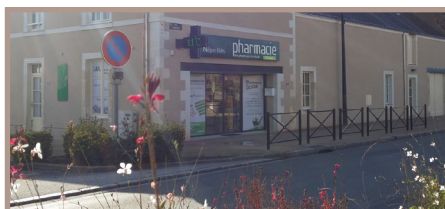
P. 6 : Les travaux en cours
