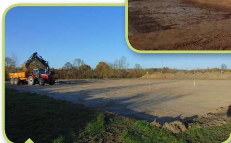
Site de la nouvelle station d'épuration au bout du chemin des Futaies.
