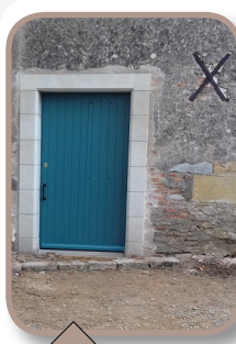
Nouvelle accessibilité à l'église de Cré-sur-Loir.
